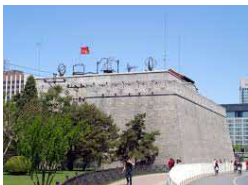
Ancien observatoire des jésuites à Beijing
